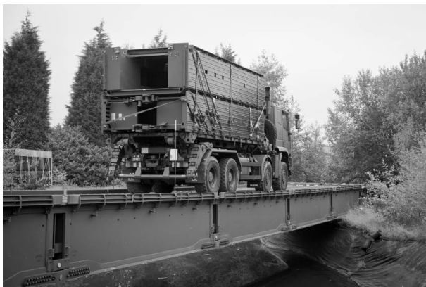
Pont d'appui 45 m à l'engagement
